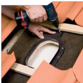
1. Monter tætningsunderlaget med skruer
