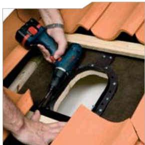
2. Fastgør beslaget med to lange skruer, ved nedeste rille
